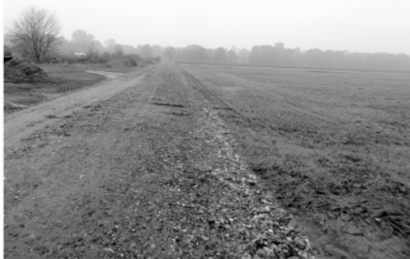
w Czempiniu wykonał prace związane z polepszeniem jakości nawierzchni z
